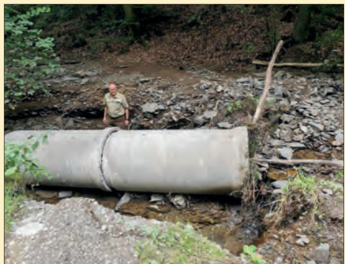
Besonders stark ausgespülter Weg: An der Querung des Laßbachs spülte die Wasserkraft das komplette Rohr frei. Normalerweise verläuft der Weg oberhalb des Rohres, das zuvor im Erdreich verborgen war. Hier wird die Chance genutzt und der Bachlauf in seinem natürlichen Bachlauf gelassen, nachdem das Rohr entfernt wurde.
